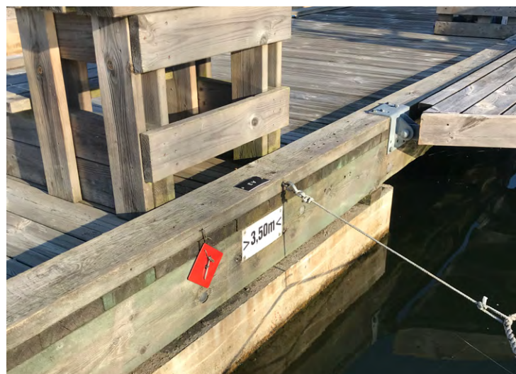
Bild 2:49 Skyltning av bredd mellan bommar. Särskilt lämpligt i gästhamnar. Foto: Bengt Fröberg.
