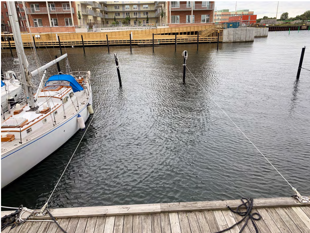
Bild 2:50 Här ett exempel på förtöjning där löplinor från stolpar till bryggan som används för att hålla båten på rätt kurs fram till bryggkanten. Foto: Jimmy Dominus.
