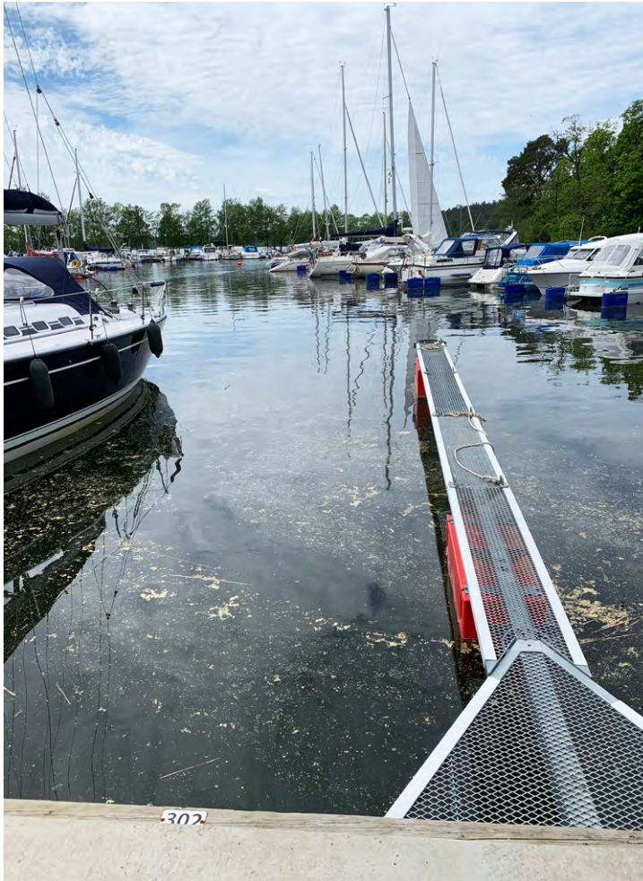
Bild 2:46 Exempel på gångbar bom, vilket ökar säkerheten. Sträckmetall att gå på minskar halkrisken jämfört med trätrall. Foto: Jimmy Dominus.
