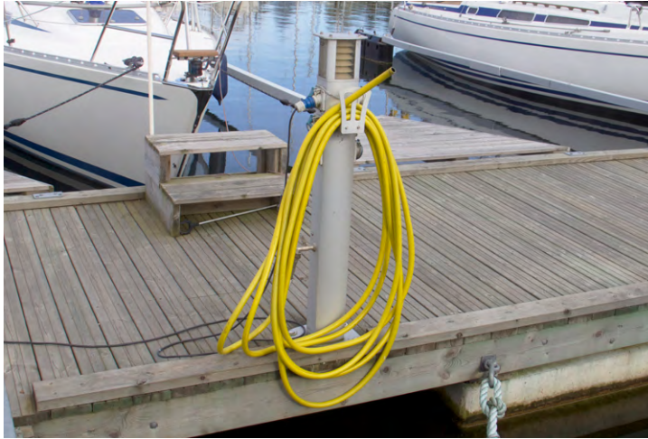
Bild 2:45 Hembyggd trappa för att göra det enklare att ta sig iland och ombord. Belysning i elstolpe. Vål avskärmad för att inte blända de som kommer med båt. Nära till el och vattenslang. Foto: Jonas Ekblad.
