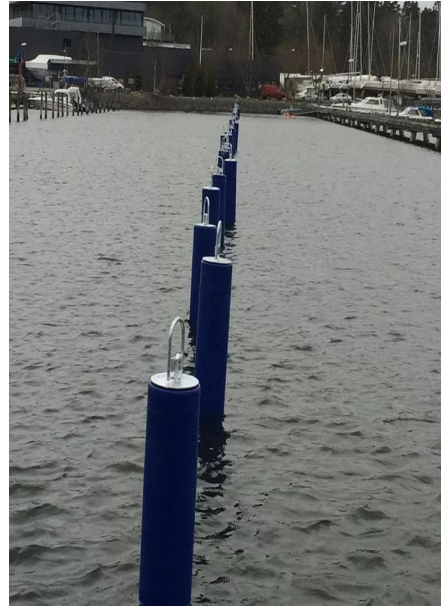
Pålbojar med sträckt förankring. Foto: Jonas Norbäck, Pontech
