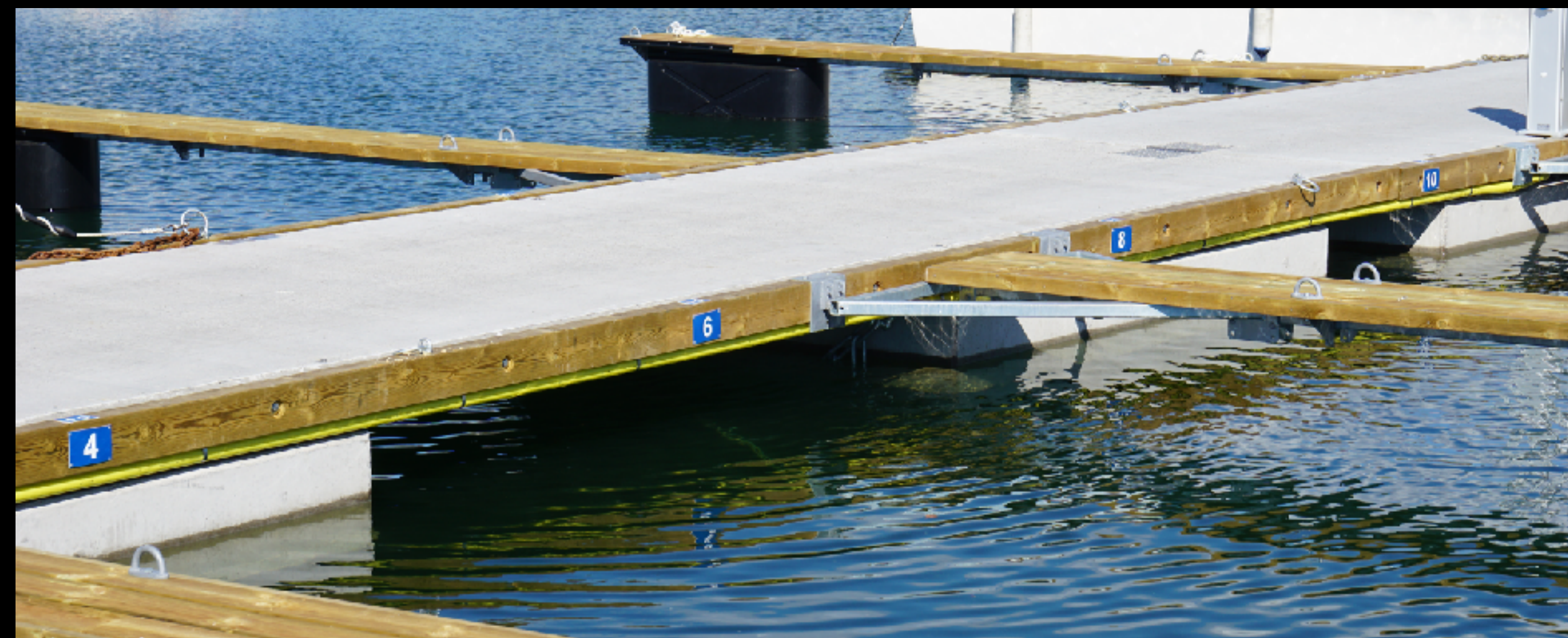
Fiberarmerad Prodock ® Beräknad livslängd 80 år med fenderbyten enligt schema
