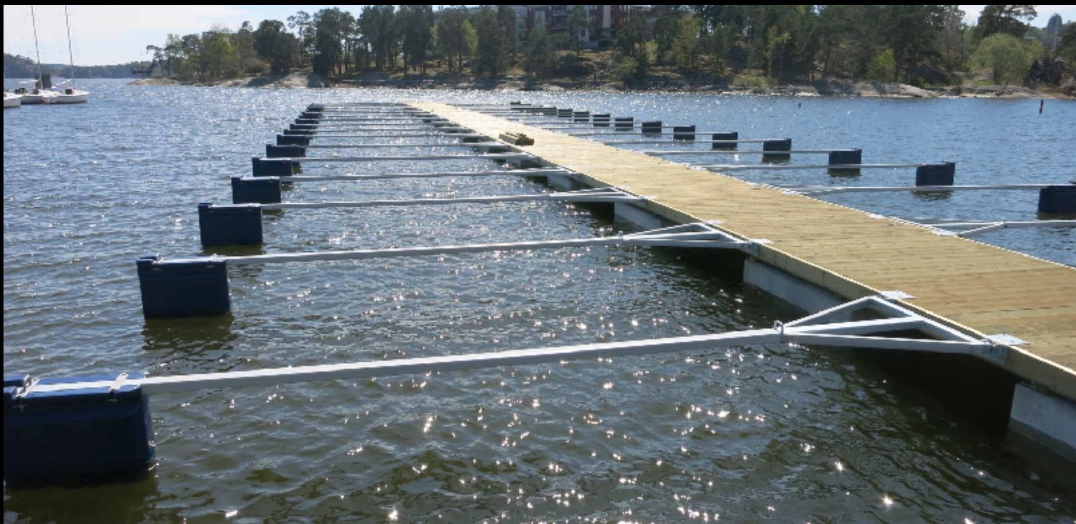
Trä-betongponton - förväntad livslängd på trädäcken - 15 år
