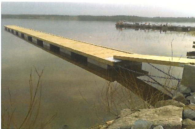
En flytbrygga uppbyggd av mindre flytblock av betong och ett upphöjt bryggdäck av tryckimpregnerat trä.
