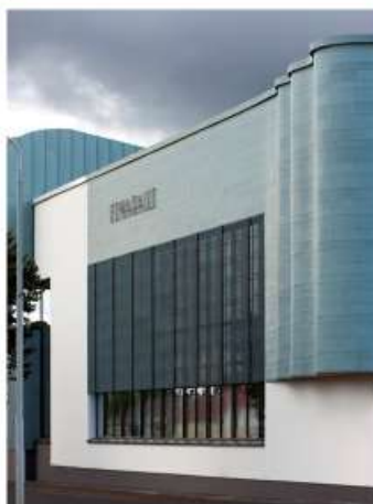
Pori Simhall Kopparfasad med inbyggd solvärmeutvinning
