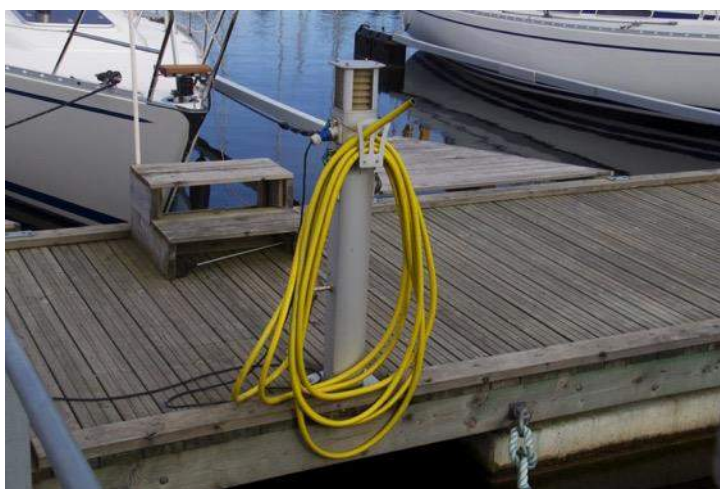
Bild 2:42 Hembyggd trappa för att göra det enklare att ta sig iland och ombord. Belysning i elstolpe. Väl avskärmd för att inte blända de som kommer med båt. Nära till el och vattenslang. (Bild: Transportstyrelsen)
