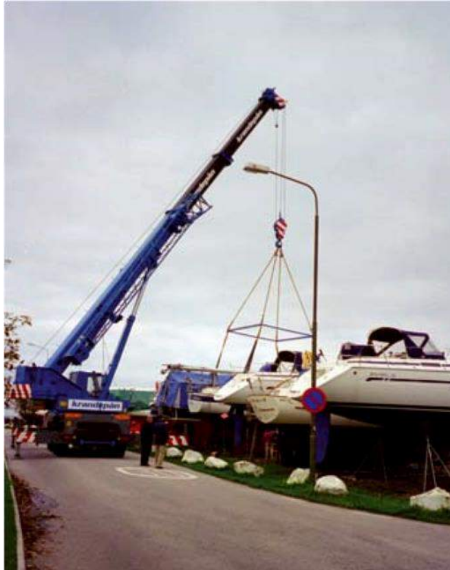
Bild. 3:3 Mobilkran. Observera att kranföraren satt ned stödbenen och inte kör med hängande last.
