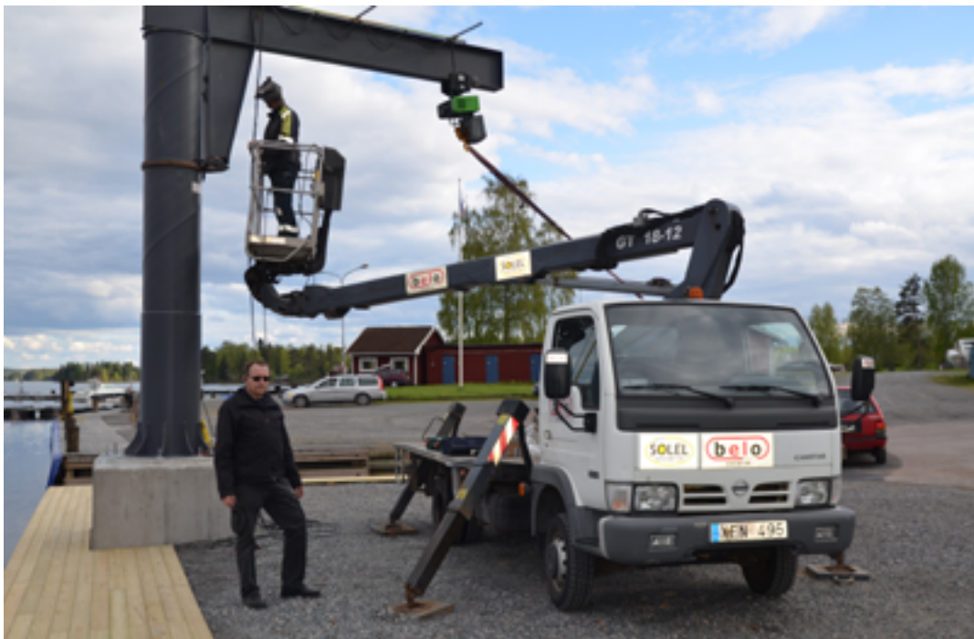
Underhåll av sjösättningskran.
